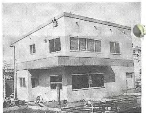
諸福営業所・新事務所。この事務所前15m長のトレーラー・スケールが持込み業者を待つ
